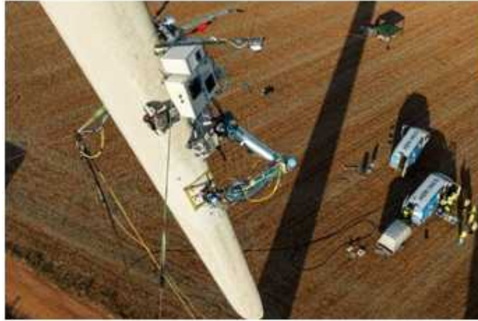
그림 9. EDP의 라 카바냐 풍력 발전소에서 진행된 수리 검증 시험 중, Tecnia 패치 적용기가 통합된 에어로네스 로봇 배치 시스템의 전경. 출처 | ROMAIN 프로젝트
