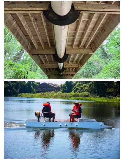
그림 10. 풍력 터빈 블레이드를 재활용하여 만든 다리 하부 및 풍력 터빈 날개로 만든 보트 (위) 미국 조지아주 애틀랜타에 최근 설치된 블레이드브리지(BladeBridge)의 아랫면으로 기증받은 풍력 발전기 블레이드를 재활용하여 중앙 지지대로 사용했고, (아래) 인도 스타트업 아크보트란시로 테크(Akvotransiro Tech)가 개발한 낚시용 쌍동선 출처 | Joseph Taylor, Re-Wind USA(위), Akvotransiro Tech(아래)
