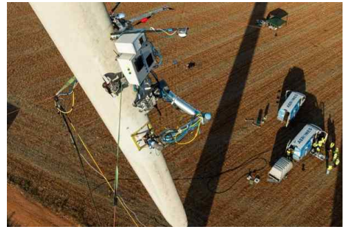
그림 3. EDP의 라 카바냐 풍력 발전소에서 진행된 수리 검증 시험 중, 테크날리아 패치 적용기가 통합된 에어로네스 로봇 배치 시스템의 전경. 출처 | ROMAIN 프로젝트
