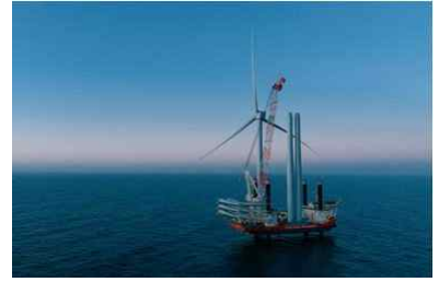
그림 11, 덴마크 서해안에서 개발 중인 1.1GW 규모의 해상 풍력 발전 단지인 토르(Thor)에는 최대 15MW 용량의 풍력 터빈 72기가 설치될 예정이다. 이 중 40기는 재활용 가능한 블레이드를 장착할 것이다. 출처 | RWE/Niklas Marc Heinecke
