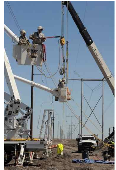
그림 14. 미국전력공사(AEP)는 CTC Global의 ACCC 도체를 설치하여 멕시코만 인근의 120마일(약 193km) 길이의 345킬로볼트 송전선로 두 곳의 용량을 두 배로 늘리고 선로 손실을 30% 줄였다. 출처 | CTC Global
