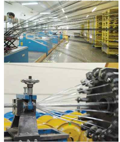
그림 12. 복합 코어를 사용한 고급 도체는 표준 장비를 사용하여 설치할 수 있다. 그림은 송전선로 종단 압축 시 금속 피팅을 압착하여 연결 (위) 하거나 종단 지점에 단단히 고정 (아래) 하는 모습을 보여준다. 출처 | CTC Global(위), Epsilon Cable(아래)
